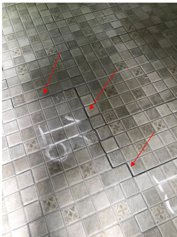
Figura 15: Trinca/Descolamento do piso na área do Imóvel nº 05 – 11 de outubro de 2021.
