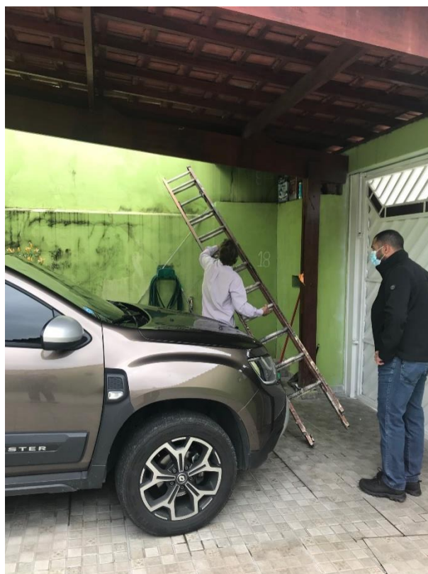
Figura 18: Acompanhamento diário das patologias no Imóvel nº 05 – 11 de outubro de 2021.
