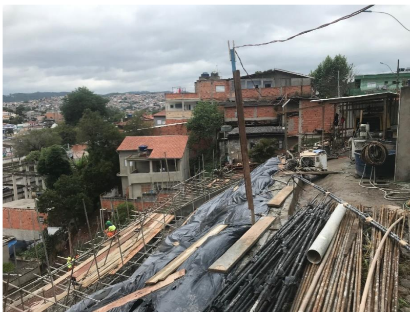
Figura 2: Vista geral da obra – 11 de outubro de 2021.
