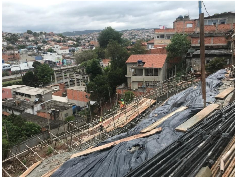
Figura 3: Vista geral da obra – 11 de outubro de 2021.
