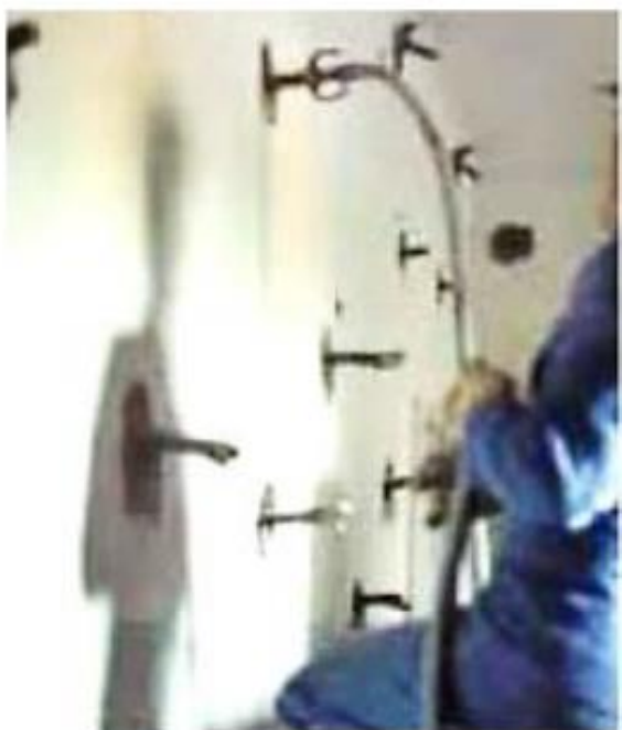
Figura 69: Ilustração de recuperação de fissura.
