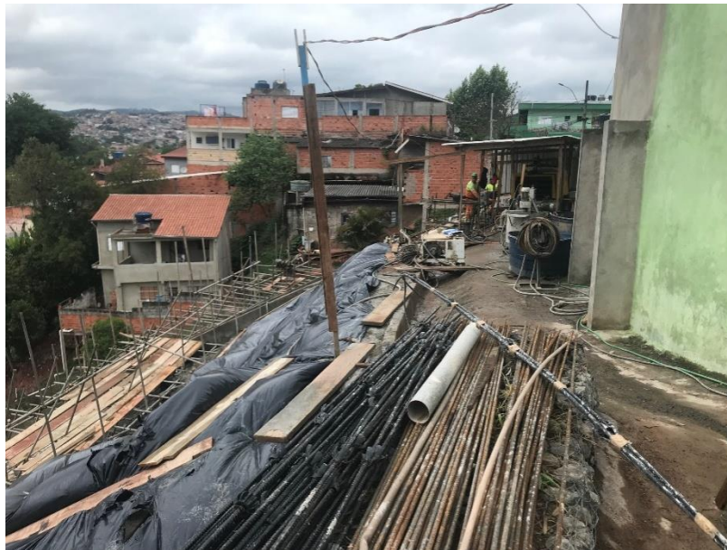
Figura 8: Vista geral da obra – 11 de outubro de 2021.
