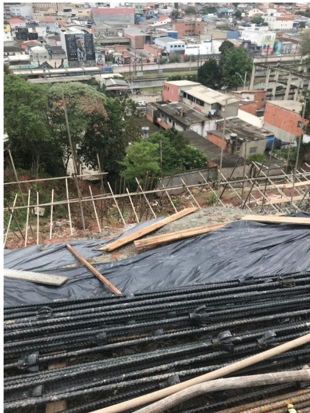
Figura 6: Vista geral da obra – 11 de outubro de 2021.
