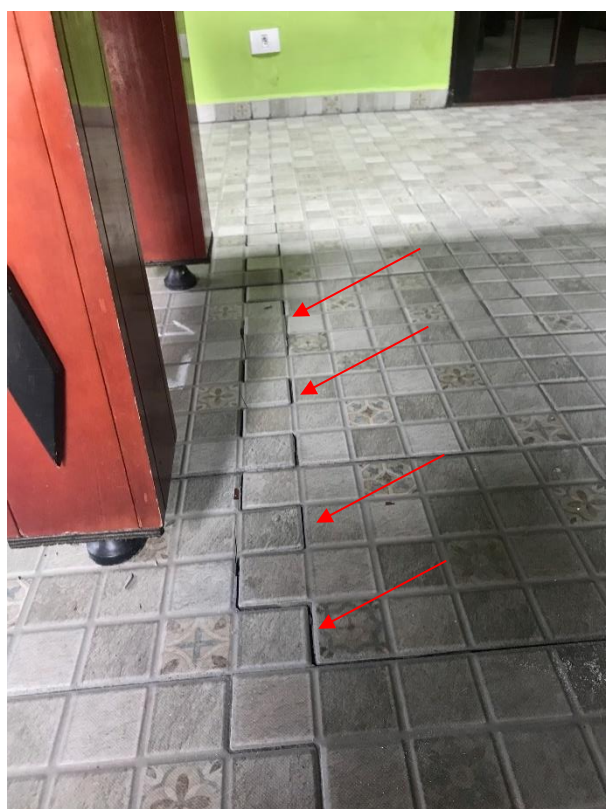
Figura 15: Trinca/Descolamento do piso na área do Imóvel nº 05 – 11 de outubro de 2021.
