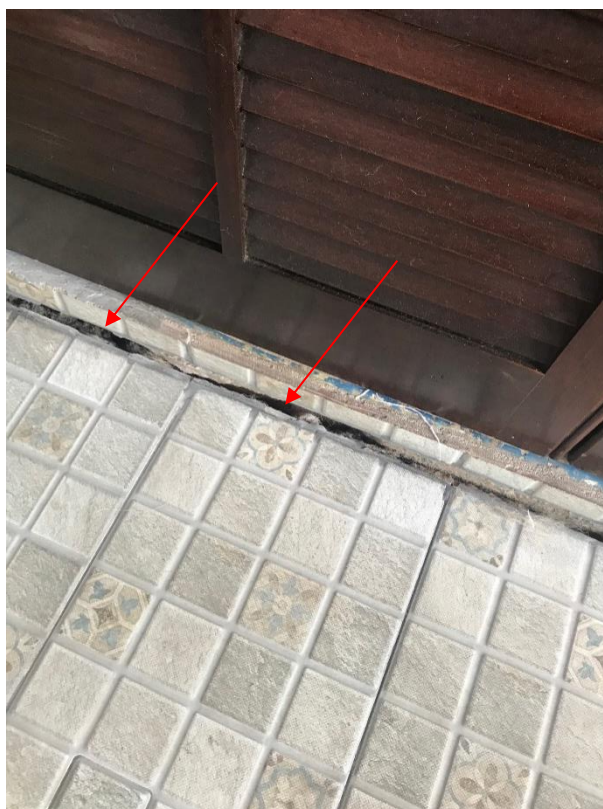
Figura 9: Descolamento/Trinca horizontal no piso junto a parede interna do imóvel vistoriado nº 05 – 11 de outubro de 2021.
