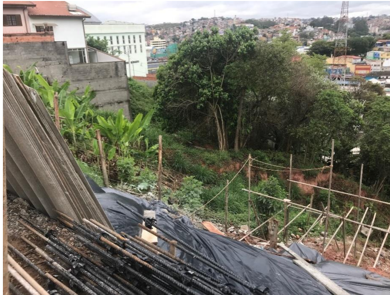
Figura 5: Vista geral da obra – 11 de outubro de 2021.
