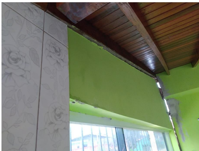
Figura 41: Trinca em parede do Imóvel nº 05 – 16 de dezembro de 2021.
