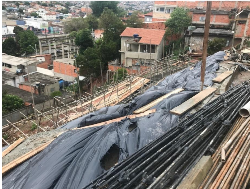
Figura 7: Vista geral da obra – 11 de outubro de 2021.
