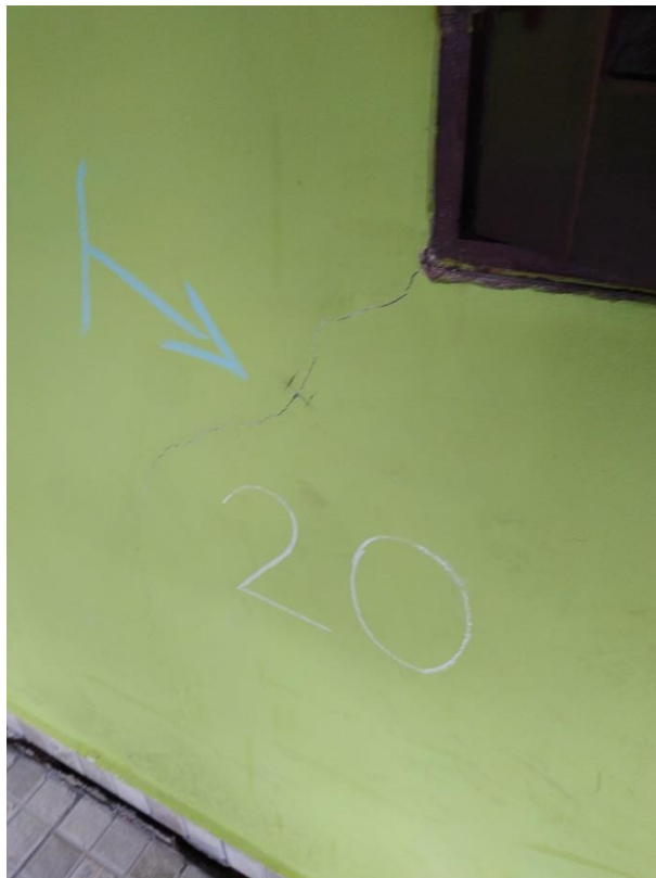
Figura 47: Trinca em parede do Imóvel nº 05 – 16 de dezembro de 2021.
