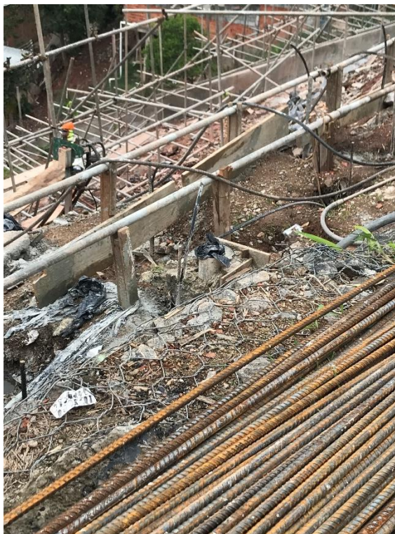
Figura 20: Vista geral da obra – 11 de outubro de 2021 – 25 de outubro de 2021.
