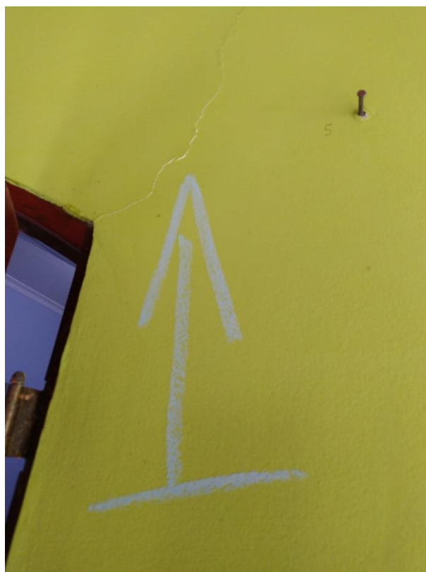
Figura 45: Trinca em parede do Imóvel nº 05 – 16 de dezembro de 2021.
