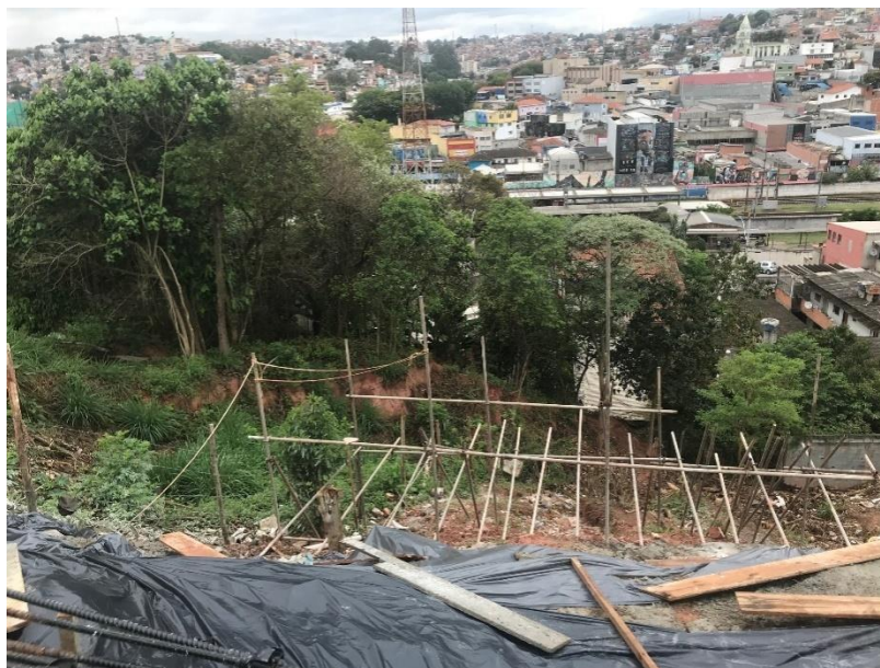
Figura 4: Vista geral da obra – 11 de outubro de 2021.
